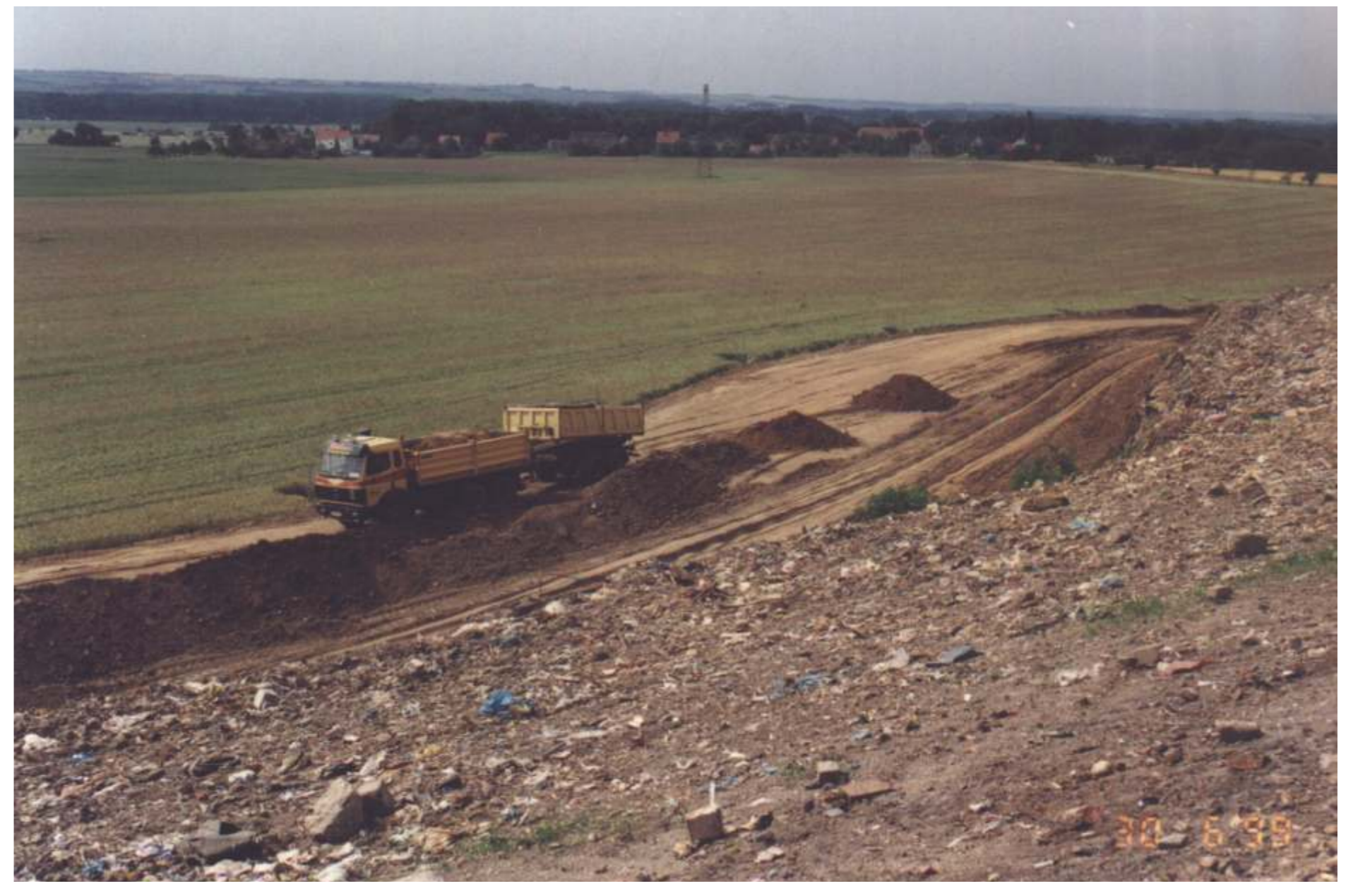
Bau des Randdammes; zukünftig nutzbar als Wirtschaftsweg
