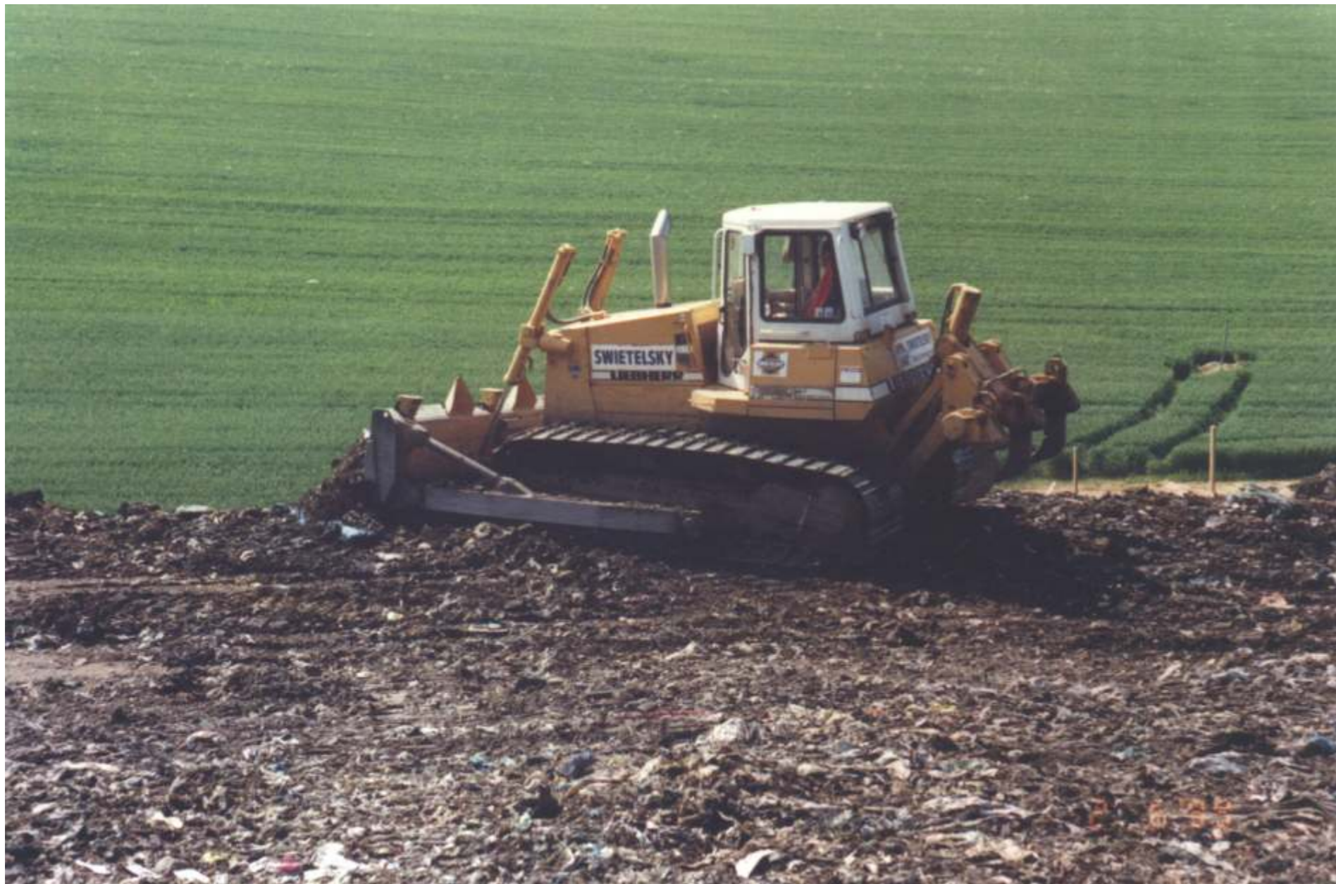
Mai 1999: Müllumlagerung und -profilierung zur Herstellung der Endform des Deponiekörpers
