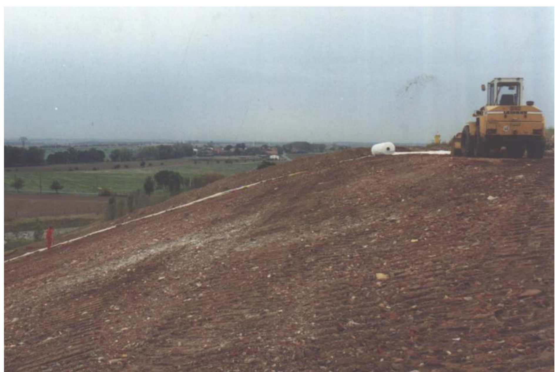
Aufbringen eines Trennfließes; darauf kommt ein halber Meter unbelasteter Boden
