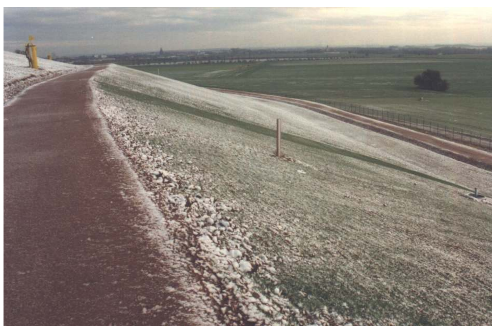
Dezember 1999: temporär abgedeckte und begrünte Südböschung
